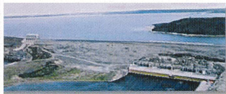
Kanadisches Wasserkraftwerk La Grande 3 (2300 MW), Photo Hydro Quebec.
