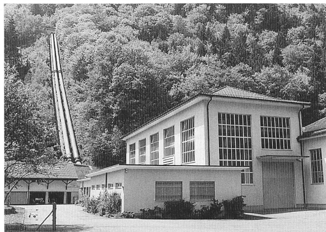
Fast 500 Wasserkraftwerke mit einer maximal möglichen Leistung ab 300 kW in der Schweiz (im Bild Kraftwerk Dallenwil/NW).
