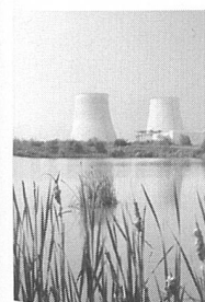
Kombikraftwerk Galileo Ferraris der Enel.
