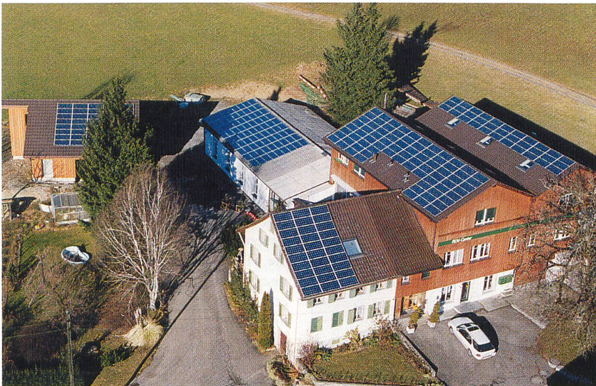
Bild 1 Strom für die Solarstrombörse: Photovoltaikanlage in Wernetshausen (ZH, Bild EKZ).
