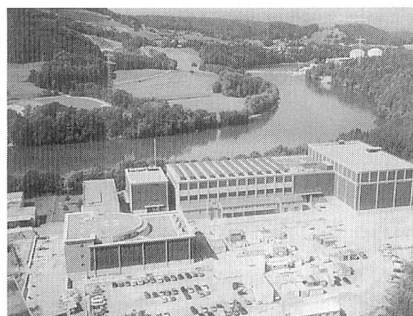
Das zentrale Zwischenlager Würenlingen aus der Vogelperspektive. Foto: Zwilag
