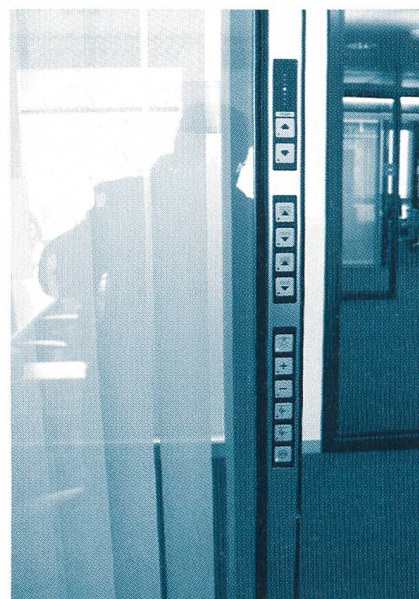
Fig. 2 Clavier sous membrane pour la commande intégrale de tous les appareillages (Source BUS-House)
