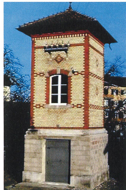
Bild 1 Antike Hülle – moderner Inhalt. Die Vielfalt der zu bewertenden Objekte ist fast grenzenlos (Trafostation).
