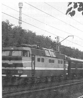
Stromabschaltungen bei der Transsibirischen Eisenbahn.
