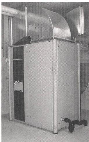
Luft/Wasser-Wärmepumpen neu auch für Heizkesselerersatz
