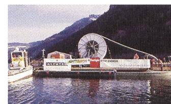
Verlegung eines 5000 Meter langen 16-kV-Kabels im Thunersee.
