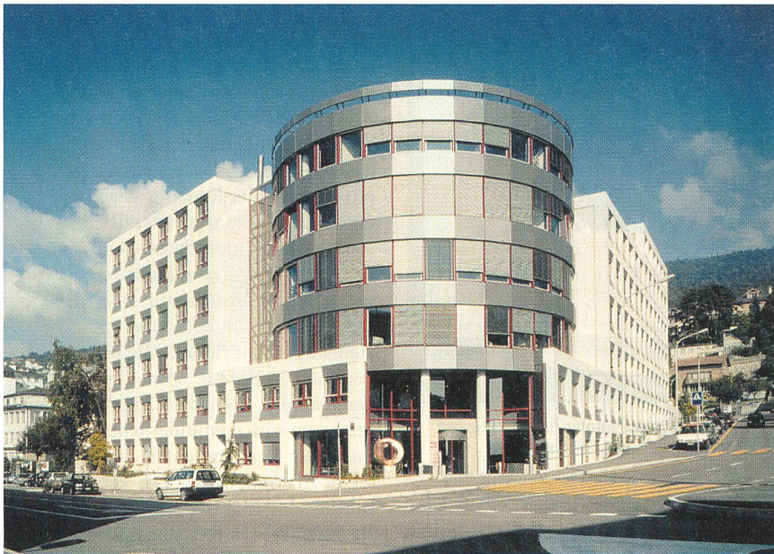
Bild 6 Testgebäude CSEM in Neuchâtel Einsatz des Neurobat-Prototypen in der Heizzone Nord-Ost
