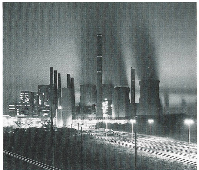
Grösstes Stromunternehmen im deutschen Markt ist die RWE AG (im Bild das Kohlekraftwerk Neurath).
