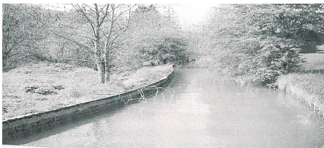
Oberwasserkanal, bevor er von 14 Erwerbslosen saniert worden ist.
