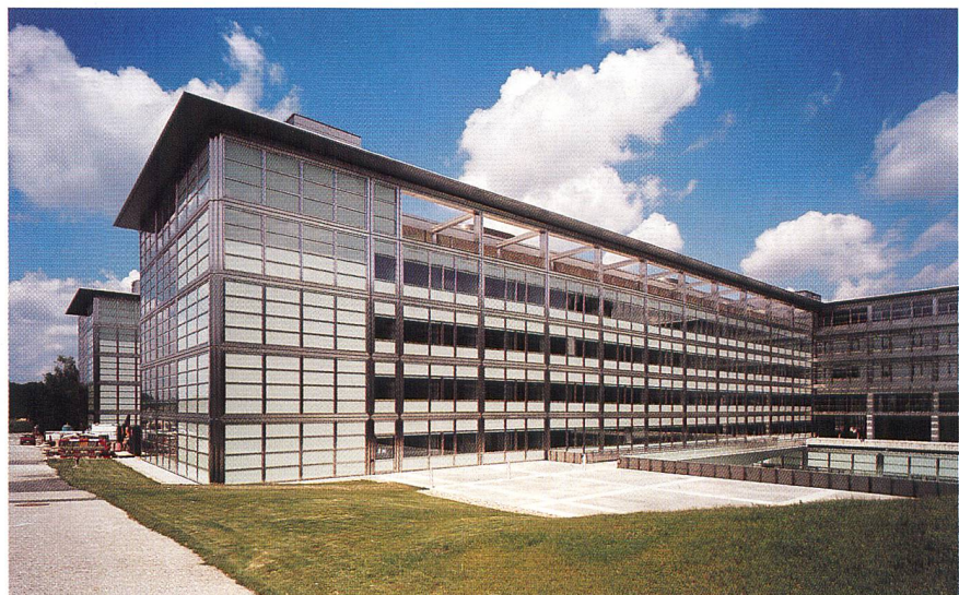
Bild 6 Die Vordächer mit den integrierten Solargeneratoren folgen der gesamten Gebäudekontur.
