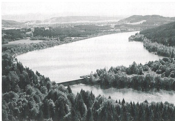
16% des Stroms in Bayern stammen aus Wasserkraft (im Bild Lechstufe 7 bei Finsterau).
