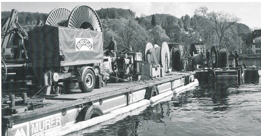
Die Kabelrolle auf dem Ponton zog das 50-kV-Kabel ein, während hinten bereits wieder neue Kabel ins Seebecken verlegt wurden.
