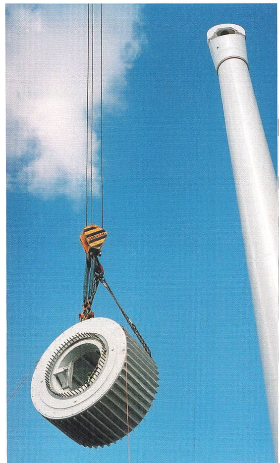
Bild 1 Die weltweit höchst gelegene Windanlage der 850-kW-Klasse ist vor kurzem auf dem Gütsch bei Andermatt montiert worden. Diese mit Unterstützung des Bundesamts für Energie (BFE) realisierte Anlage soll die Funktionstüchtigkeit in alpinem Klima bestätigen.
