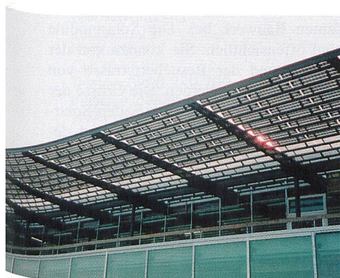
Bild 1 Beschattungselemente auf der Nordseite (Fotos: R. Durot).
