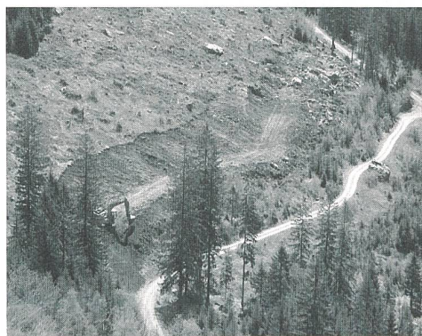
Arbeiten auf der 1. Ausbaustufe «Roslari» (Bild: KWO).
