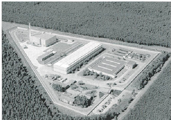
Zentrales Zwischenlager Gorleben (D).
