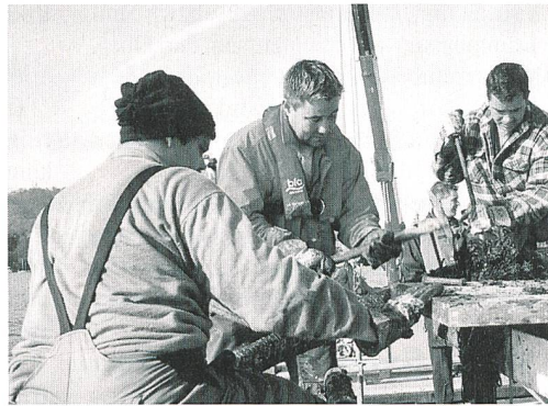
Vor dem Aufrollen musste am Kabel die Ummantelung aus Jutte mit dem ganzen Schlick entfernt werden.
