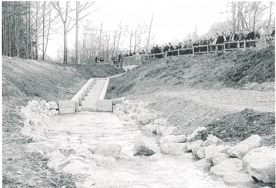
Nicht nur die Fische werden die neue Treppe benutzen. Auch die Biber an der Aare sollen die Gewässer sicher wechseln können (Bild: BKW).
