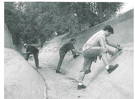
Sanierung der Oberwasser-Kanalmauer im Team.
