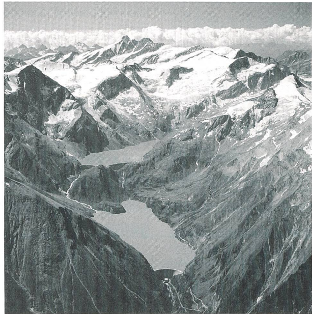
Kaprun mit seinen beiden Speichern Mooserboden und Wasserfallboden ist eines der grössten Kraftwerke des Verbunds.
