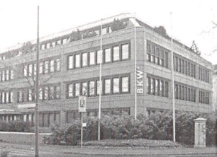
Die Bernische Kraftwerke benutzen für das umfassende Messdatenmanagement Silo-SQL
