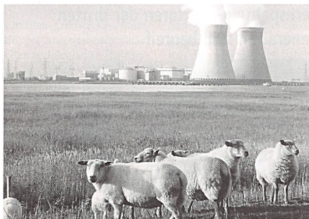
Belgisches Kernkraftwerk Doel.
