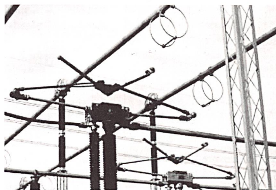
Teurer Zugang zum Stromnetz (Bild EON).
