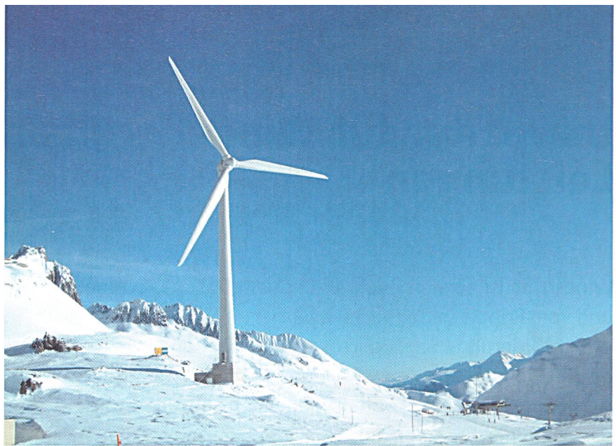
Bild 4 Moderne 800-kW-Windenergieanlage bei Gütsch oberhalb von Andermatt
