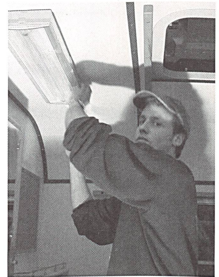
Stromversorgung in neuen Zirkuswagen: eine typische Arbeit in der Winterpause für Markus Bühler und seine Kollegen.
