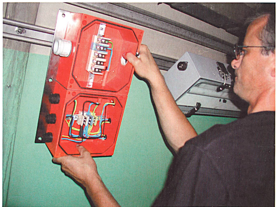
Bild 3 Montage einer Doppelabzweigdose und Notleuchte für Autobahnstrassentunnel, obere AZ-Dose zur Schlaufung, untere zur Lampenanspeisung.
