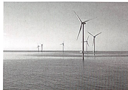
Hier soll der grösste Offshore-Windpark der Welt entstehen (Arklow Sandbank vor Wicklow; Bild Airtricity).
