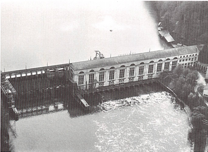
Das Wasserkraftwerk Mühleberg entstand 1917 bis 1920 in der wirtschaftlich schwierigen Zeit des Ersten Weltkrieges. Es liegt zwischen dem Felsenau-Kraftwerk der Stadt Bern und der Saanemündung in Mühleberg. Auf dieser Strecke können 20 m Gefälle der Aare für die Stromproduktion genutzt werden.
