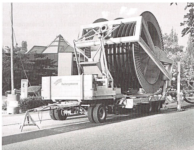
Flexible Fernwärmeführung vor der Montage, Bild links.
