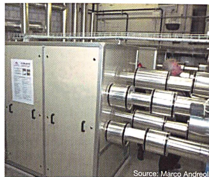
Figure 3 Modèle de pompe à chaleur d'une puissance thermique de 264 kilowatts qui puise son énergie dans le sol au moyen d'un réseau de sondes géothermiques
