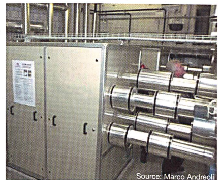
Figure 3 Modèle de pompe à chaleur d'une puissance thermique de 264 kilowatts qui puise son énergie dans le sol au moyen d'un réseau de sondes géothermiques
