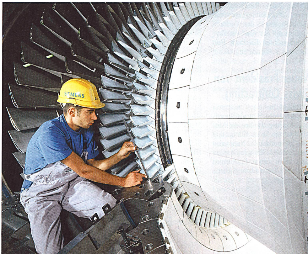
Montagearbeiten an einer 3A-Gasturbine im Berliner Werk des Unternehmens (Bild Siemens).
