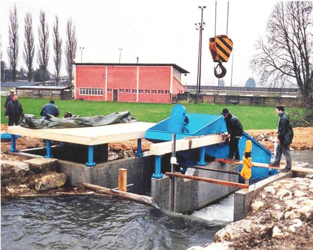
Montage der kompakten Einheit der Wasserkraftschnecke im Grützbach bei Derendingen (SO).
