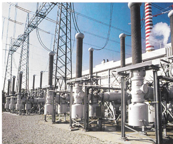
Hochintegrierte Schaltanlage.
