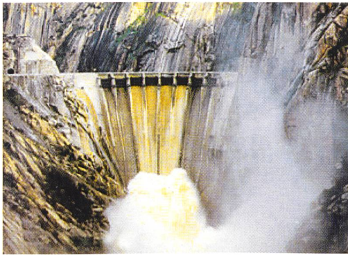
Spanische und portugiesische Versorger können bald auf der gesamten iberischen Halbinsel Strom anbieten (grösstes Wasserkraftwerk in Spanien: Aldeadavila / Foto Iberdrola).
