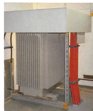
Kompakt-Abschirmssystem PowerShield von Systron EMV GmbH für Transformatoren bis 1250 kVA
