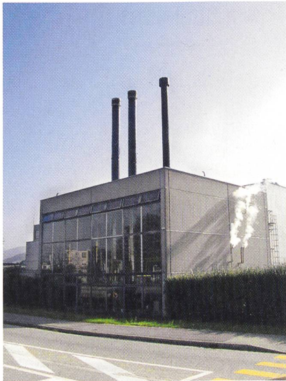
Heizzentrale Buss Industriepark, Pratteln (Bild: ebl).
