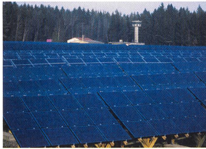
Die zurzeit noch grösste Photovoltaikanlage der Welt in Hemau bei Regensburg (Bild: voltwerk AG)
