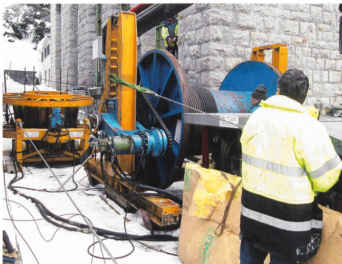
Aufwändige Windeneinrichtung zum Einzug der Trageile, betrieben durch Sepp von Rotz (r.), Seilbahnbauunternehmer aus Kerns (Bilder: kwo).
