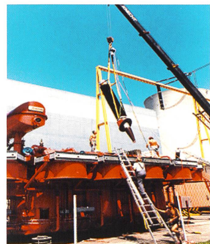
Figure 3 Travaux de remise à niveau sur site sur transformateurs 400 kV
