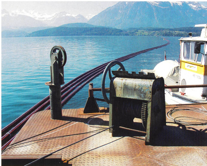
Neue Kabelrohre im Thunersee zwischen Spiez und Oberhofen (Bild: bkw).
