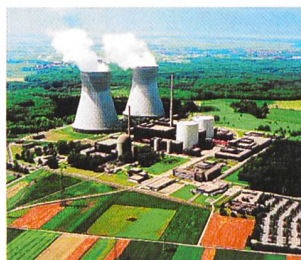
Die Option Kernenergie sei offen zu halten: Kernkraftwerk Gundremmingen Block B und C (1344 MW) mit Siedewasserreaktoren (Bild Areva).
