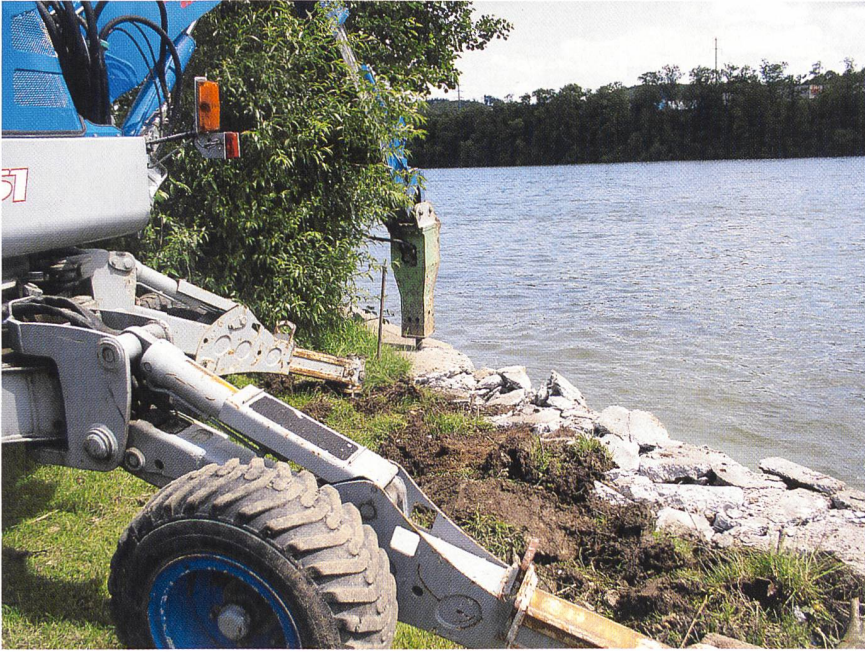
Uferverbauungen werden entfernt (Bilder: energiedienst).
