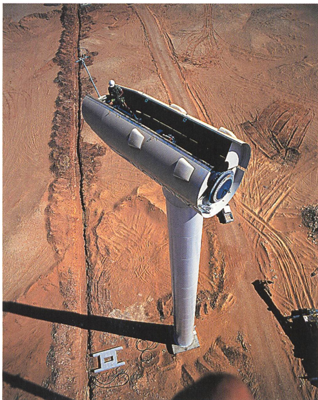
Kaum neue Arbeitsplätze durch den Ausbau erneuerbarer Energien? (Bau einer Windkraftanlage/Bild Nordex)
