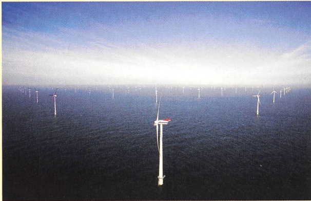
Horns Rev, 15 km vor der dänischen Westküste, ist mit 160 MW einer der grössten Windparks weltweit (Bild Elsam).
