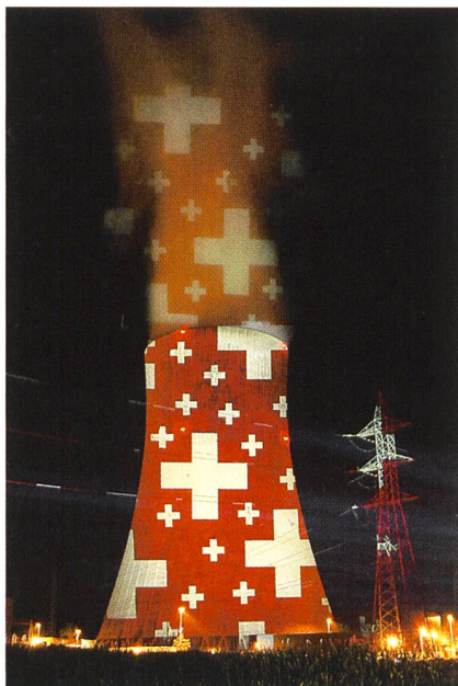
Ende August wurde der Kühlturm des Kernkraftwerks Gösgen (SO) von Gerry Hofstetter aus dem Helikopter mit speziellen Motiven beleuchtet (Fotograf: Erwin von Arx, KKG).
