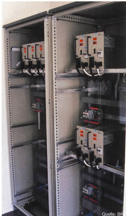
Bild 2 Getaktete Gleichrichter
