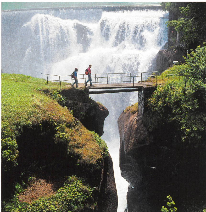
Comment les énergies renouvelables seront-elles soutenues (passerelle sur la Reuss au barrage de Pfaffensprung (UR)/photo Swiss-Image/Lucia Degonda)?
