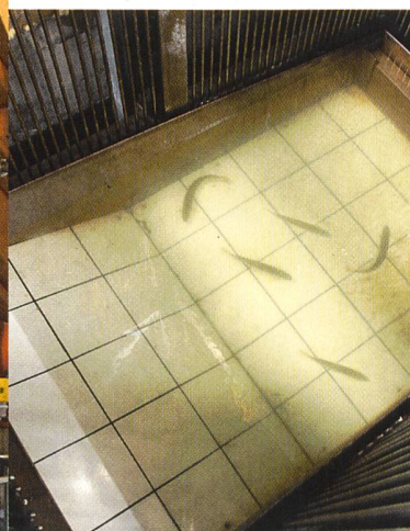
Fischlift und Aufzugswanne im Kraftwerk Magere Au. Damit können die Fische auch einen Staudamm überwinden (Bilder: few).
