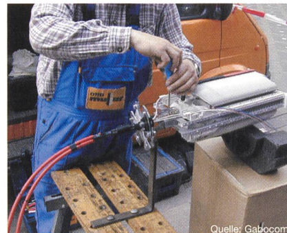
Bild 3 Spleissen der Kabel Die Mikrokabel werden in der Gel-Muffe ausserhalb des Schachtes montiert.
